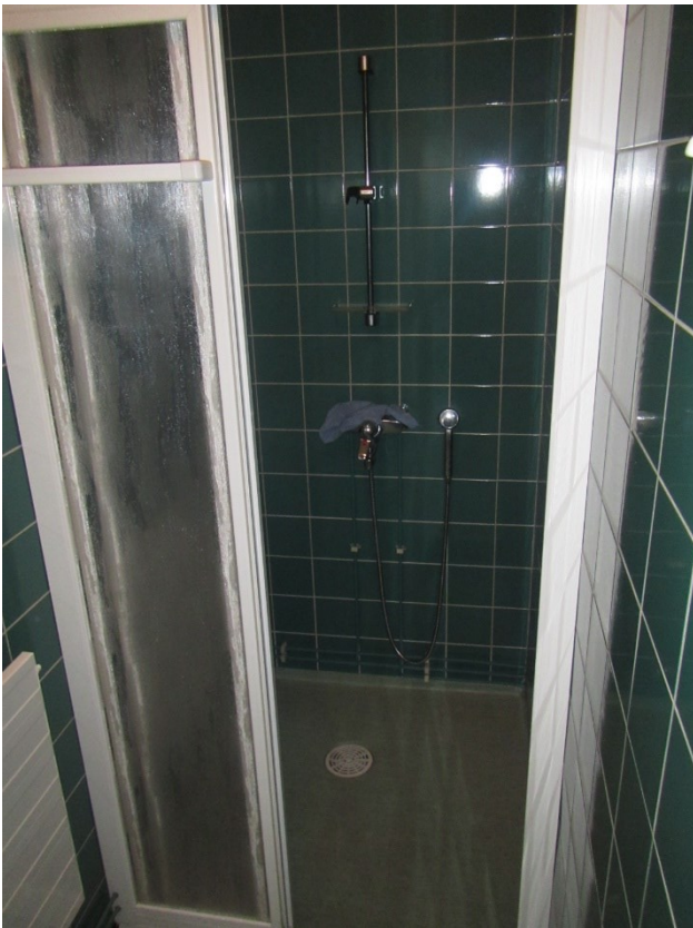
KUVA 5: Miesten pukuhuoneen suihkutila.
