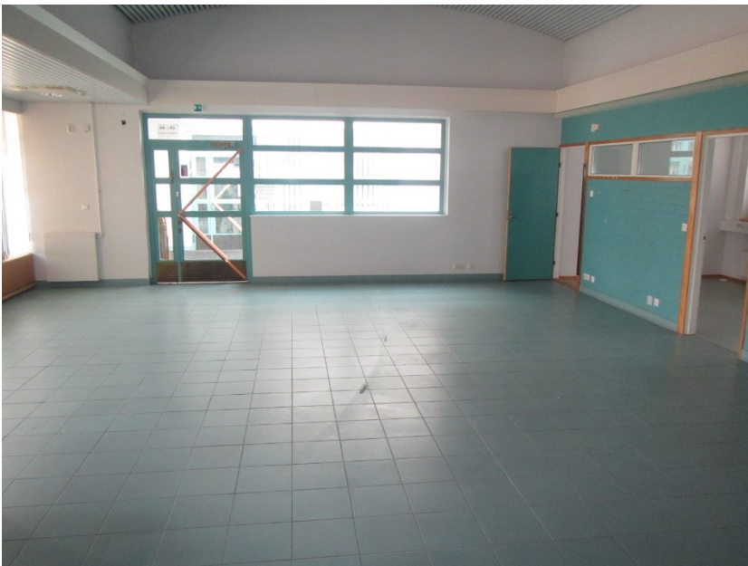
KUVA 2: Asiakaspalvelutila. Lattian pintarakenteena asiakaspalvelutilaan soveltuva, kulutusta kestävä ke-raaminen laatoitus. Pintarakenteen muuttamista suositellaan harkitsemaan, mikäli tila muutetaan toimisto-tilaksi.
